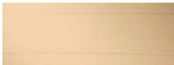
鍍波(コテナみ)仕上げ
